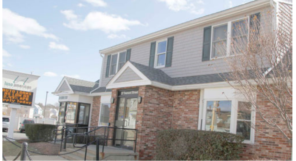
O primeiro edifício da Luso American Credit Union em Peabody
